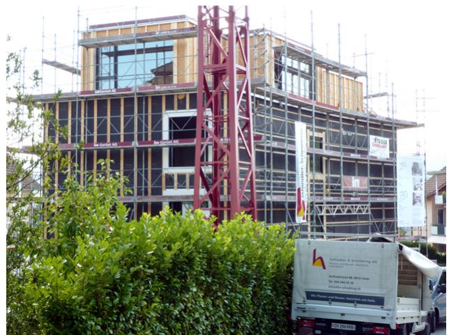
Aussenansicht strassenbseitig von oben im Rohbau
