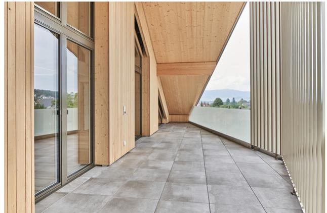
Im Dorfzentrum von Gretzenbach im Kanton Solothurn entstand ein Holzbau mit zwölf Wohnungen und einem Dorfladen. Die Balkone kragen über 3.5 Meter aus – dies ohne störende Stützen. Eine ausgeklügelte, aufgehängte Konstruktion macht es möglich.
