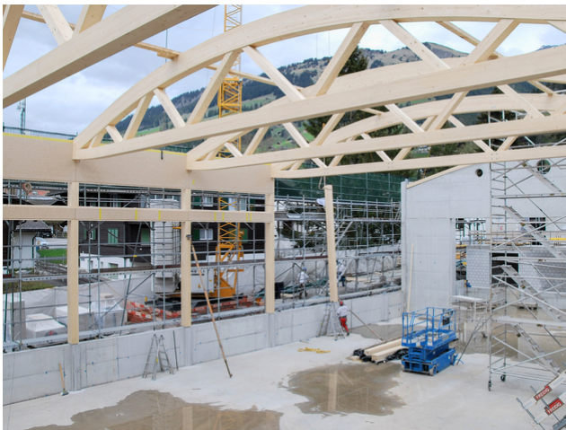
Mehr Tragkonstruktionshöhe durch den leicht nach oben gekrümmten Untergurt der Fachwerkträger
