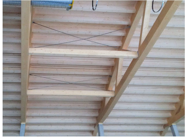
Die stabilisierende Konstruktion nimmt die Kräfte der Sportgeräte auf
