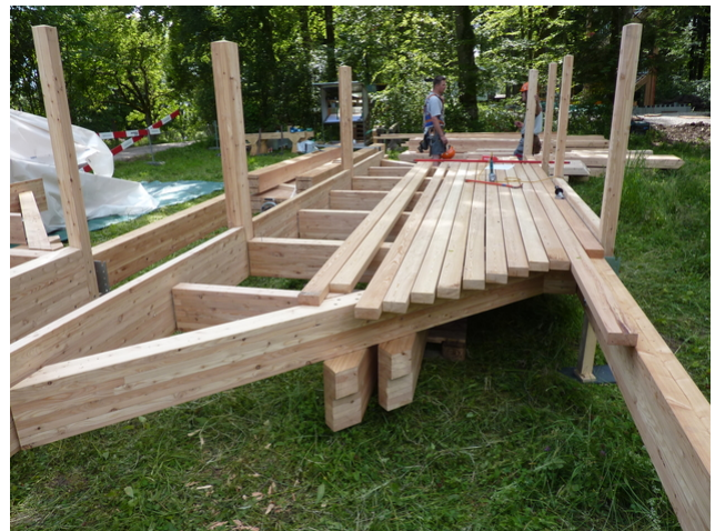
Zusammenbau des Turms
