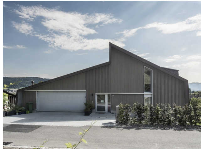
Die Garage direkt über dem Schlafzimmer stellte hohe Anforderungen an den Schallschutz
