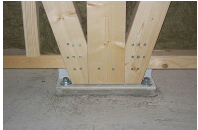
Verankerung Erdbeben-Aussteifung
