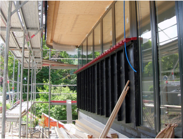
Auskragende Geschossdecke im Bereich des Zugangs
