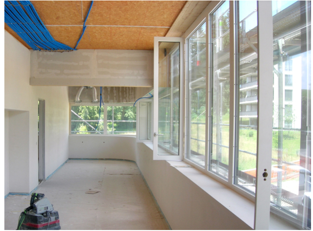
Arbeitsnische mit auskragendem BSH Unterzug
