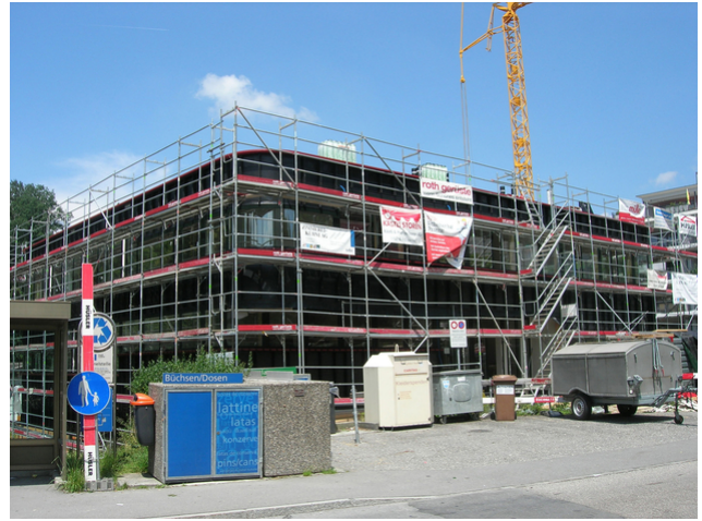
Aussenansicht von der Büthenbergstrasse
