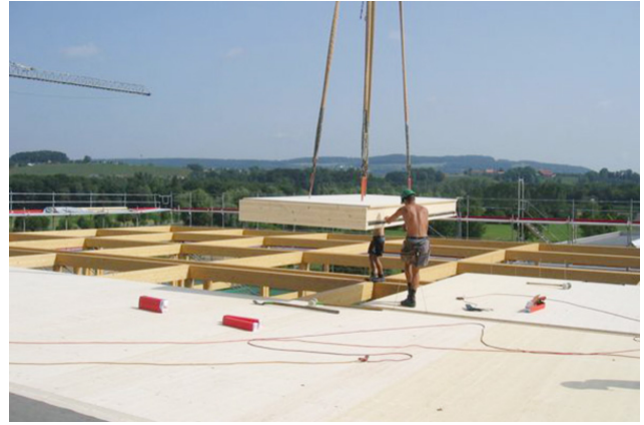
Montage von Dachelementen
