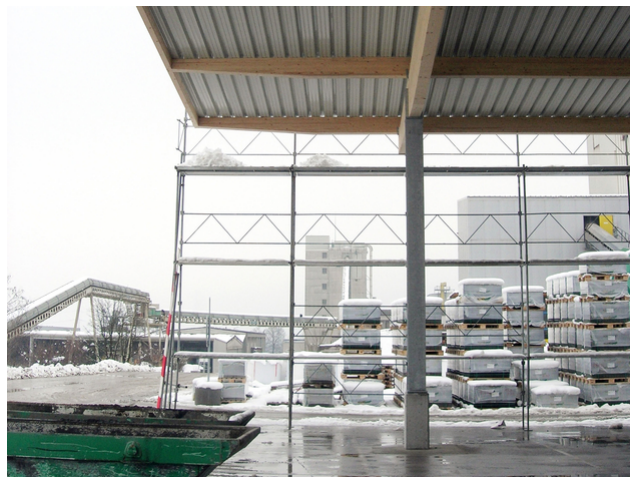
Stahlstütze und Holzbinder
