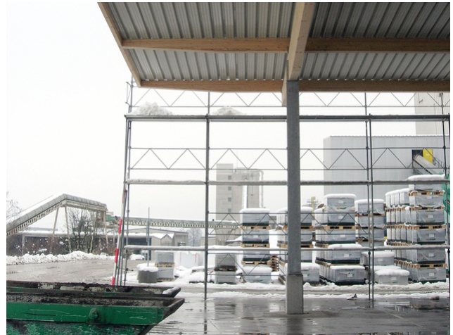
Stahlstütze und Holzbinder
