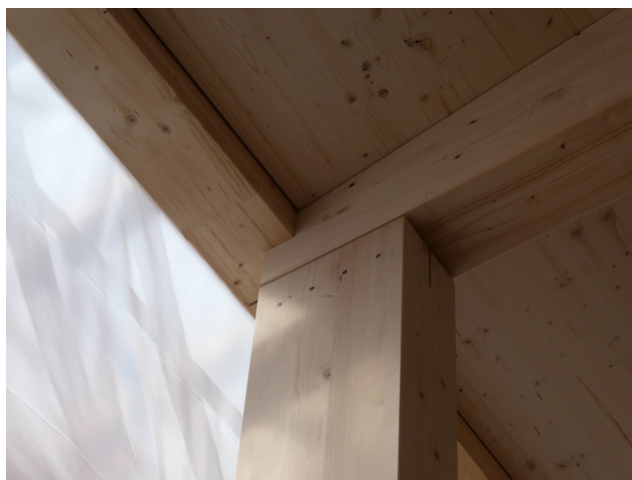
Auflager Träger auf Stütze
