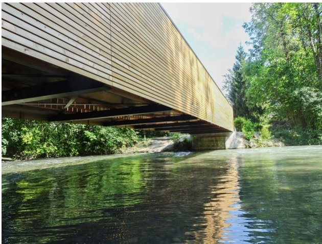
Genügend Platz zwischen der Wasseroberfläche und der Brücke
