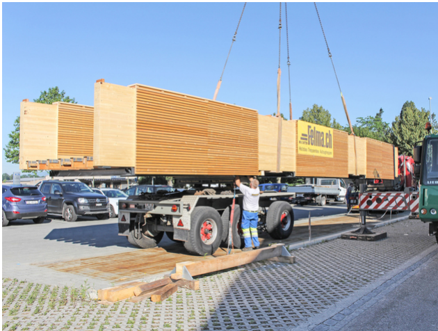
Unterwegs: die Brücke wurde in einem Stück transportiert
