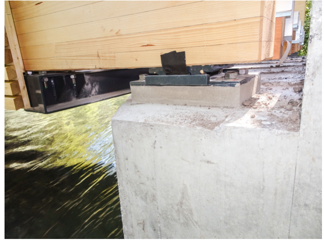
Die neue Brücke wurde auf die vorhandenen Abutments montiert
