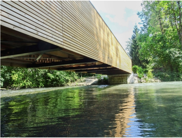
Genügend Platz zwischen der Wasseroberfläche und der Brücke
