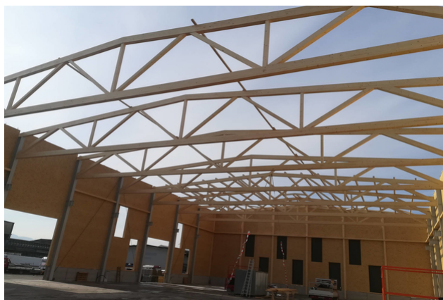
Montage Produktionshalle
