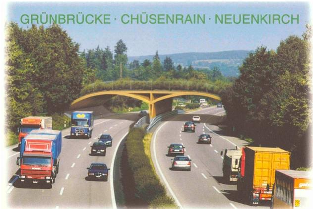
Eine Grünbrücke in Holz über eine vierspurige Autobahn zu bauen, ist eine besondere Herausforderung. Auch wenn bis zum ersten Spatenstich noch viel Wasser die Reuss hinunter fließen wird, so zeigt die erstellte Studie doch Ansätze für eine sichere und dauerhafte Lösung.
