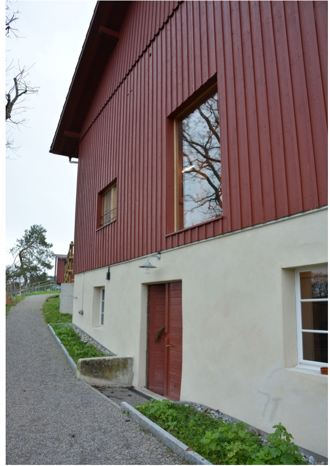
Rot gestrichene Fassade
