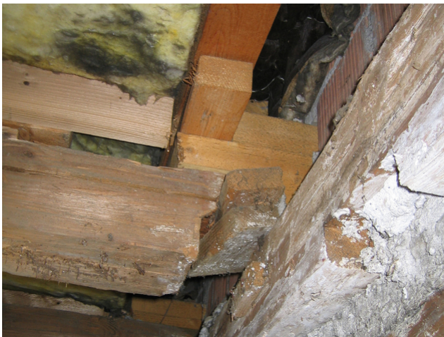
Trägerunterstützung OG vor der Sanierung
