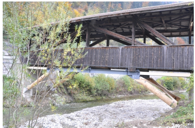
Ansicht der Brücke nach der Sanierung
