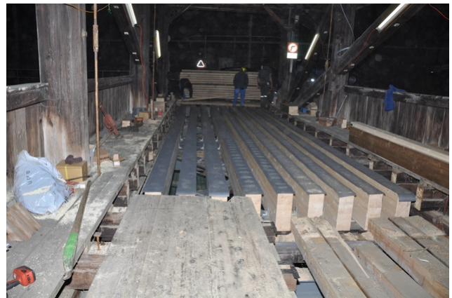
Montage neue Längsträger in der Nacht
