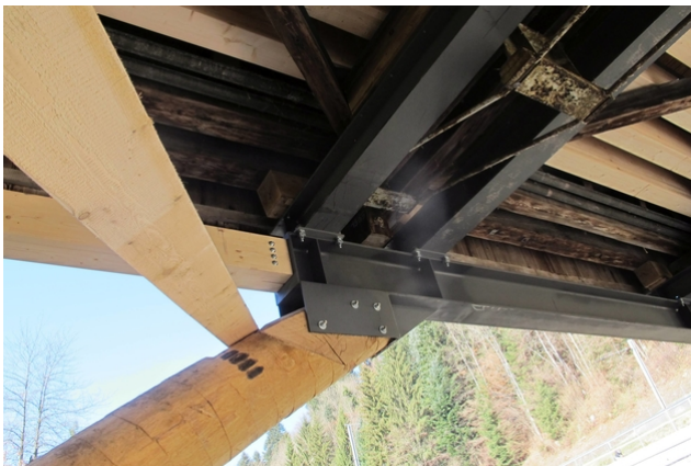
Anschluss der Eichenstämmen und Druckstäbe
