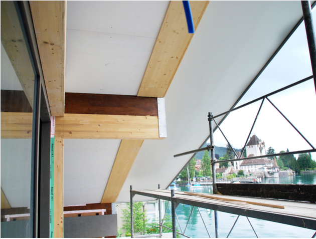
Gartensaal mit Hohlkastendecke
