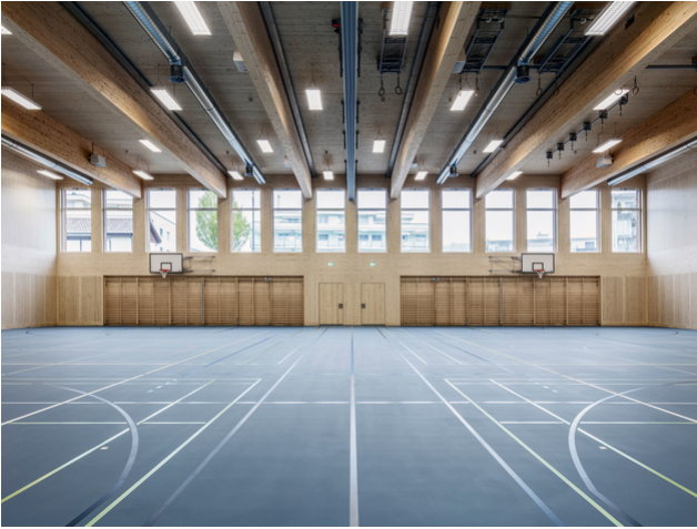
Die Wände und die Decke der Turnhalle sind aus Holz
