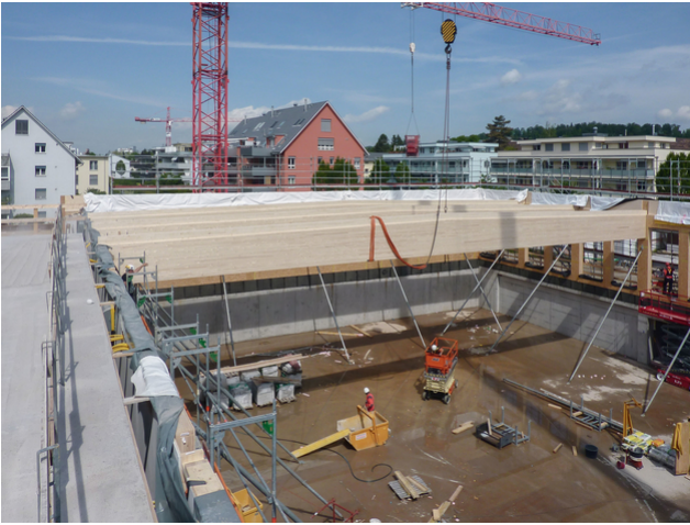
Einbau von Dachgepäckträgern für die neue Sporthalle
