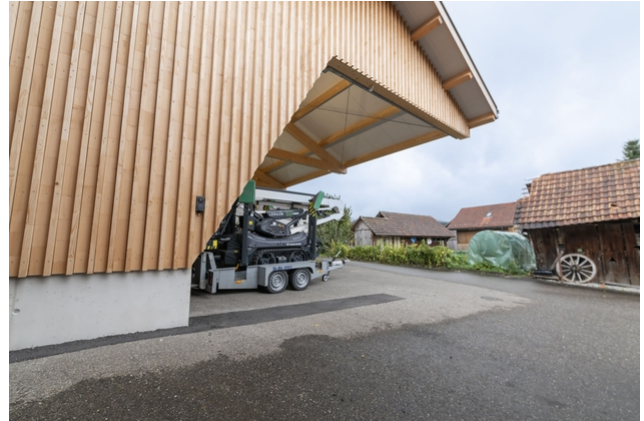
weit auskragende Dachkonstruktion
