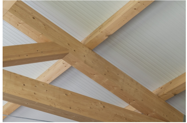
Detailsicht auf die innenliegende Bockkonstruktion des Holzfachwerks
