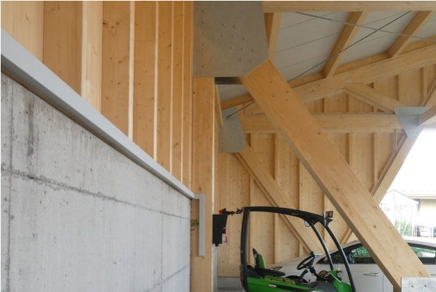
Ansicht Bockkonstruktion des Holzfachwerks
