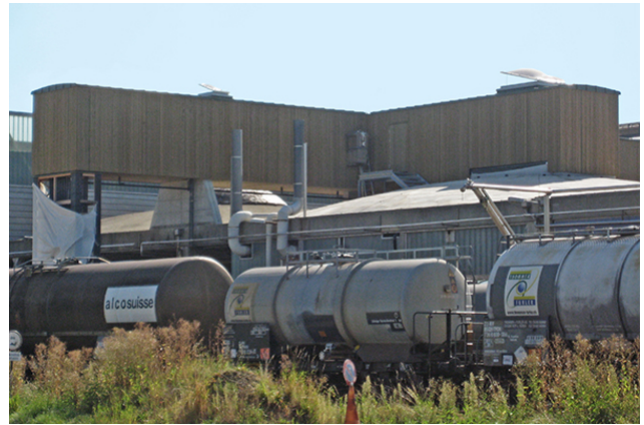
Befüllung vom Gleis
